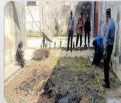
Proses Pengukuran konstruksi ruang baca anak dan ruang penyimpanan peralatan kerja
